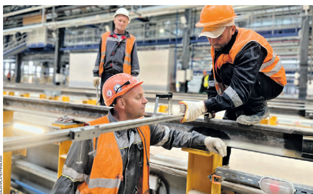
3 июня 10:33 Рабочие (слева направо) Олег Нурылев, Сергей Мышлянов и Эдуард Парасковей проверяют смонтированные пути в электродепо «Аминьевское»
